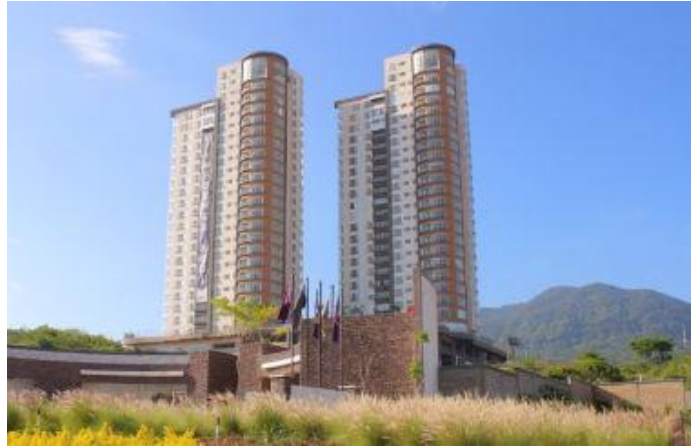
Edificio “Torres Kaan Luxury Towers”
