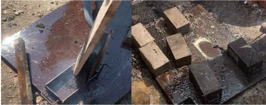
Figura 35. Proceso de elaboración de tabiques.
