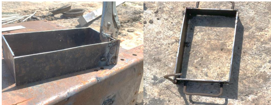
Figura 31. Fabricación de moldes para tabiques.
