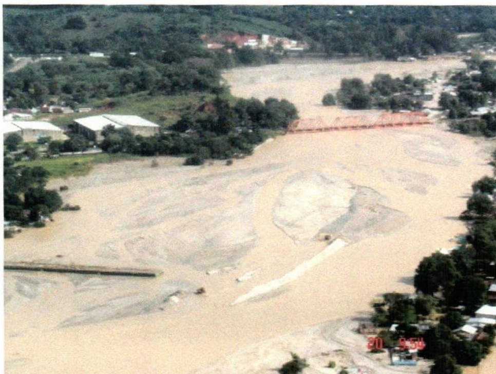
Foto 4. Daños sufridos a la infraestructura y vías de comunicación de la cuenca de estudio (Huixtla).
