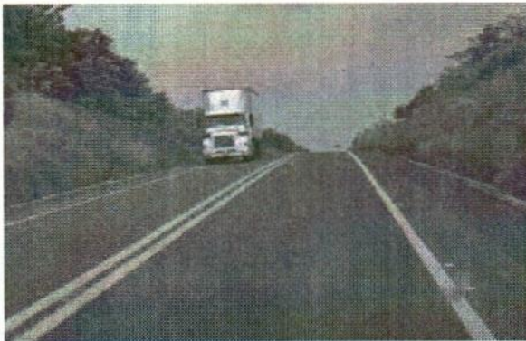
Foto 1. Carretera Ocozocoahutla - Tuxtla Gutiérrez.
