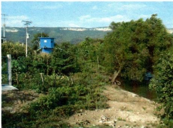
Foto 7. Sitio de muestreo, se observa la planta de captación muy cerca al punto de muestreo. Esta agua es distribuida a los habitantes de la localidad de Pacú municipio de Suchiapa,
