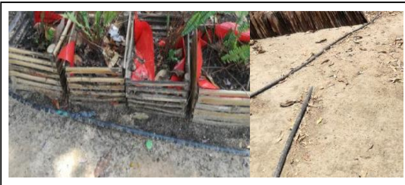
Figura 20. Distribución con tuberías dentro del terreno.
