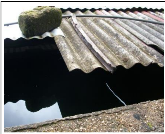
Figura 35. Tanque de almacenamiento de agua de lluvia.
