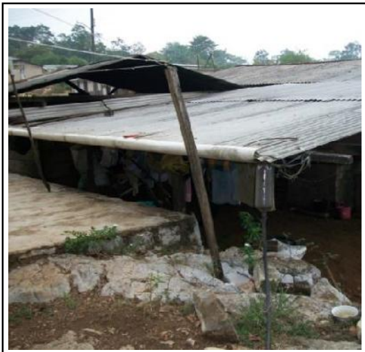
Figura 34. Sistema para la captación de agua de lluvia
