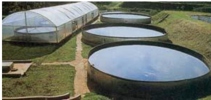
Figura 10. Estanques de Geomembrana
