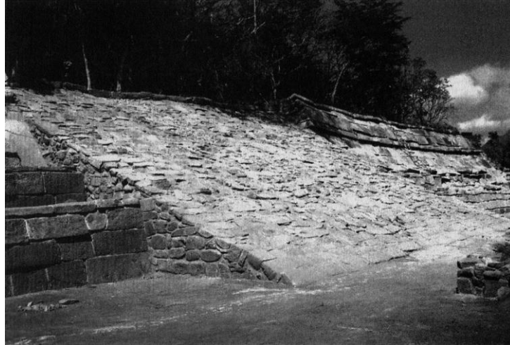
Figura 58. Detalle de la rampa de acceso principal a la estructura B-1 de Iglesia Vieja (Tomado de Kaneko 2006).
