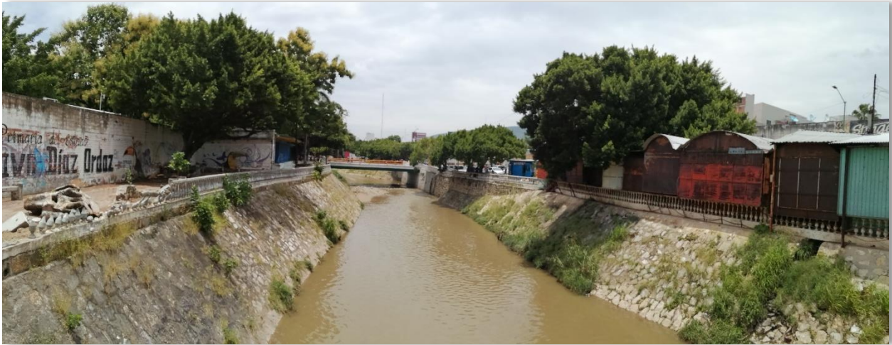
Puente y andadores de la 5ª Poniente entre 4ª y 5 Av. Norte, a la derecha se puede contemplar la continuidad del tianguis mencionado, a la izquierda se pueden ver los barandales deteriorados del andador y la Escuela Primaria Gustavo Díaz Ordaz. Foto tomada viendo hacia el lado poniente. Foto 188.
