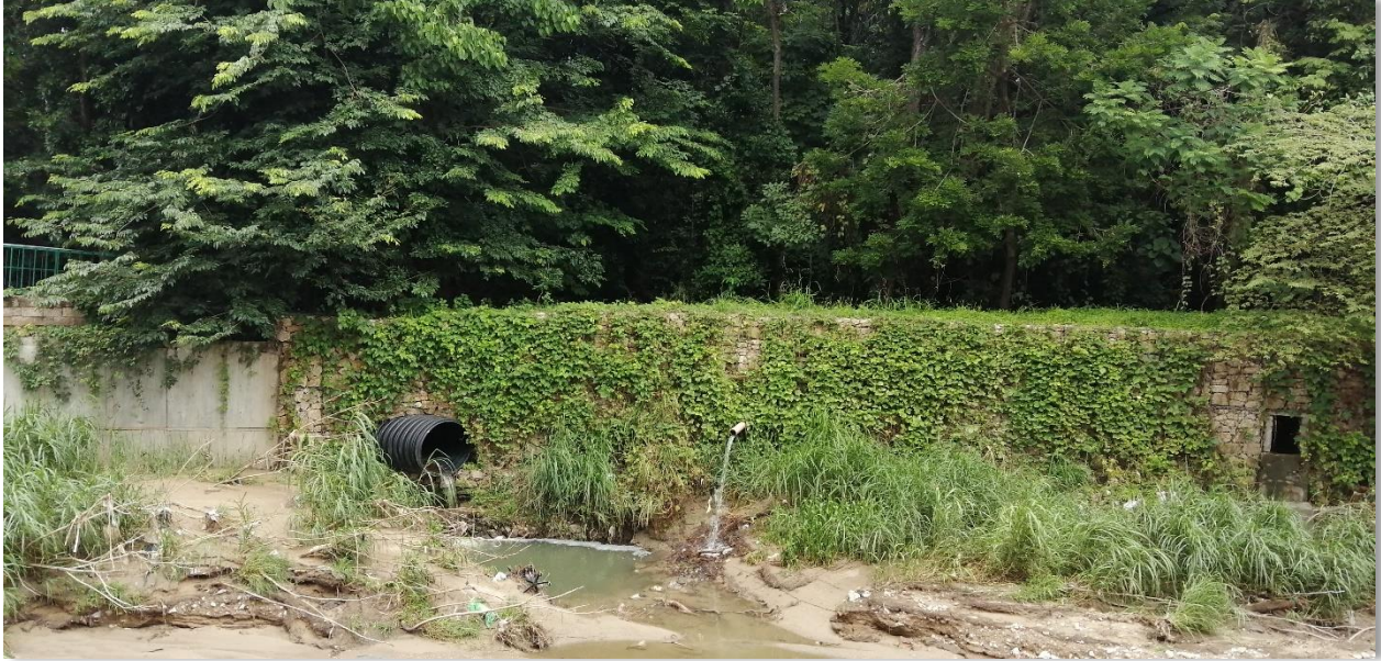
Panorámica del andador y la vegetación del Jardín Botánico Dr. Faustino Miranda, al fondo se puede observar dos desagües, la tubería más grande de lado izquierdo desemboca agua contaminada de drenajes, la tubería pequeña de lado derecho desemboca agua limpia de una vertiente embovedada, el agua limpia y sucia caen juntas mezclándose.
