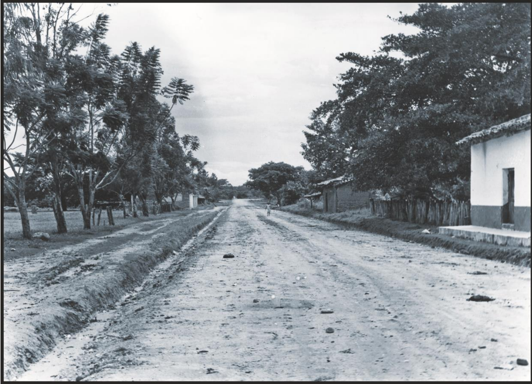
Fotografía de los años 50 s de la calle de El Rastro actualmente conocida como La Calzada Ignacio Zaragoza, actualmente La Calzada conserva su acervo ambiental en terrenos baldíos y pese al potencial de su vegetación puede ser recatado para volverse vivero y a la vez parque recreativo, así como, El Jardín Botánico Dr. Faustino Miranda. En sí, hay terrenos baldíos de tamaño considerado en Tuxtla Gutiérrez cuya vegetación es buena y merecen ser rescatado. Foto 122.
