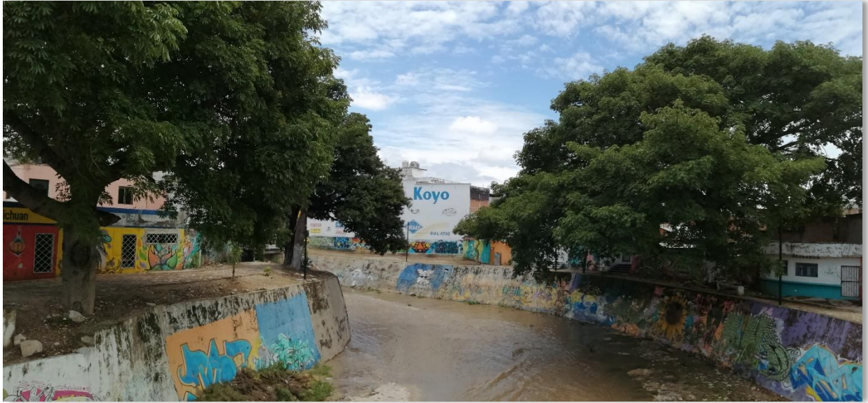
Puente de la Calle Central entre 4 a Norte Poniente y 5 Av. Norte, foto capturada hacia el lado oriente. Foto 178.
