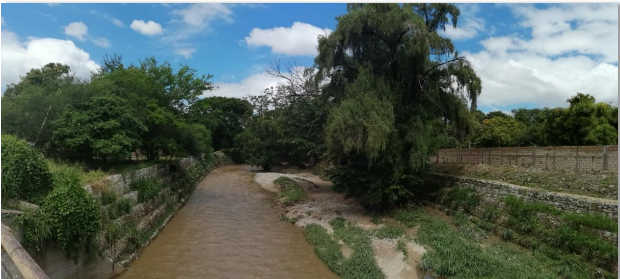
Puente de La 20 Oriente y Boulevard Ignacio Zaragoza. Foto 141.
