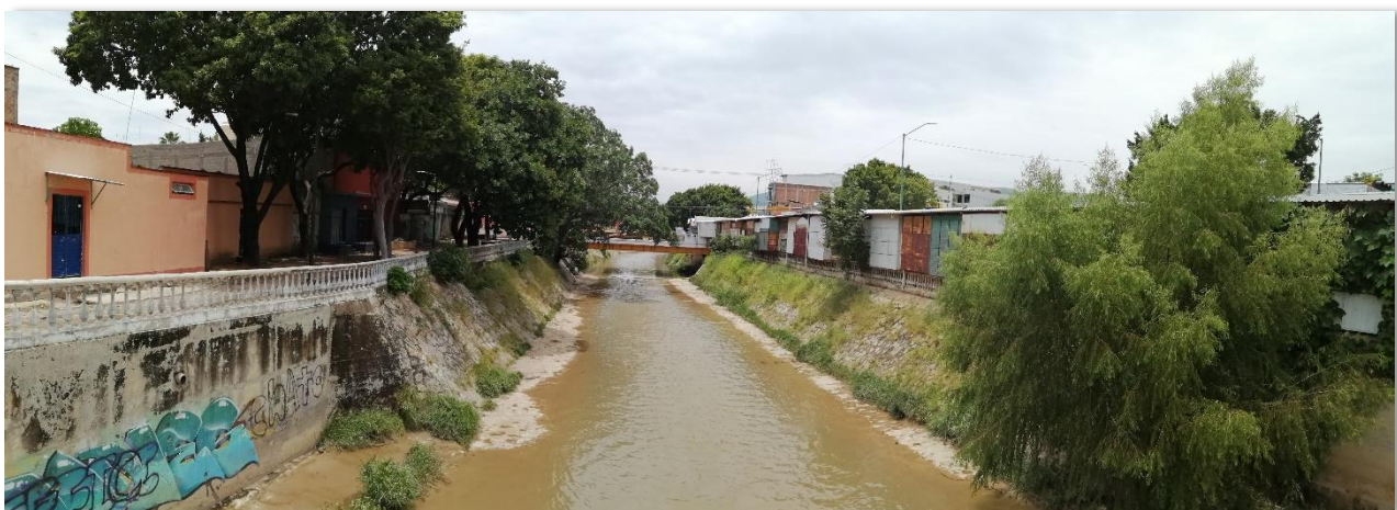
Mismo puente y andadores de la 4ª Poniente entre 4ª y 5 Av. Norte, de lado derecha de puede apreciar un joven árbol de sabino y el tianguis conocido como "La Fayuca". Foto capturada viendo hacia el lado poniente. Foto 187.
