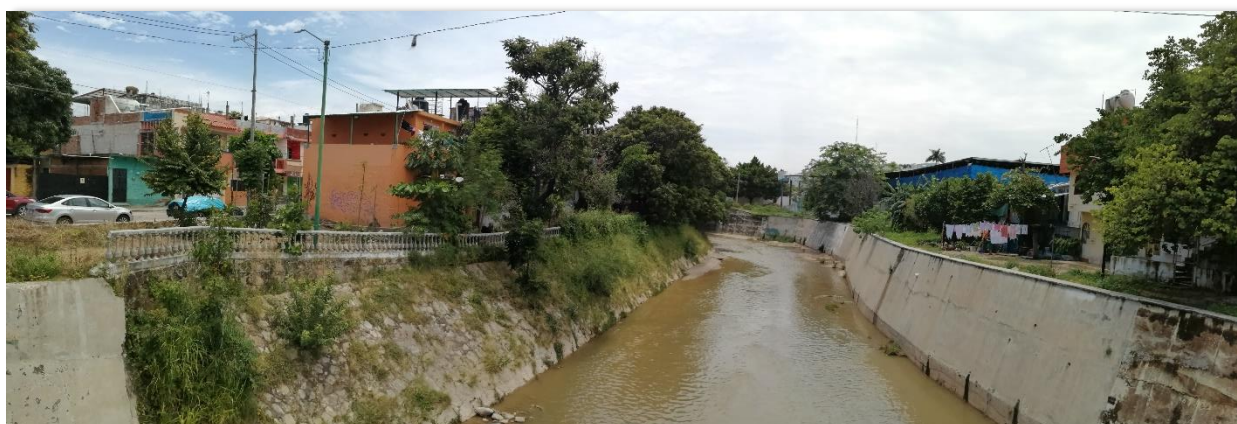
Puente y andadores de la 10ª Poniente entre 4ª y 5 Av. Norte, fotografía tomada viendo hacia el lado poniente.
