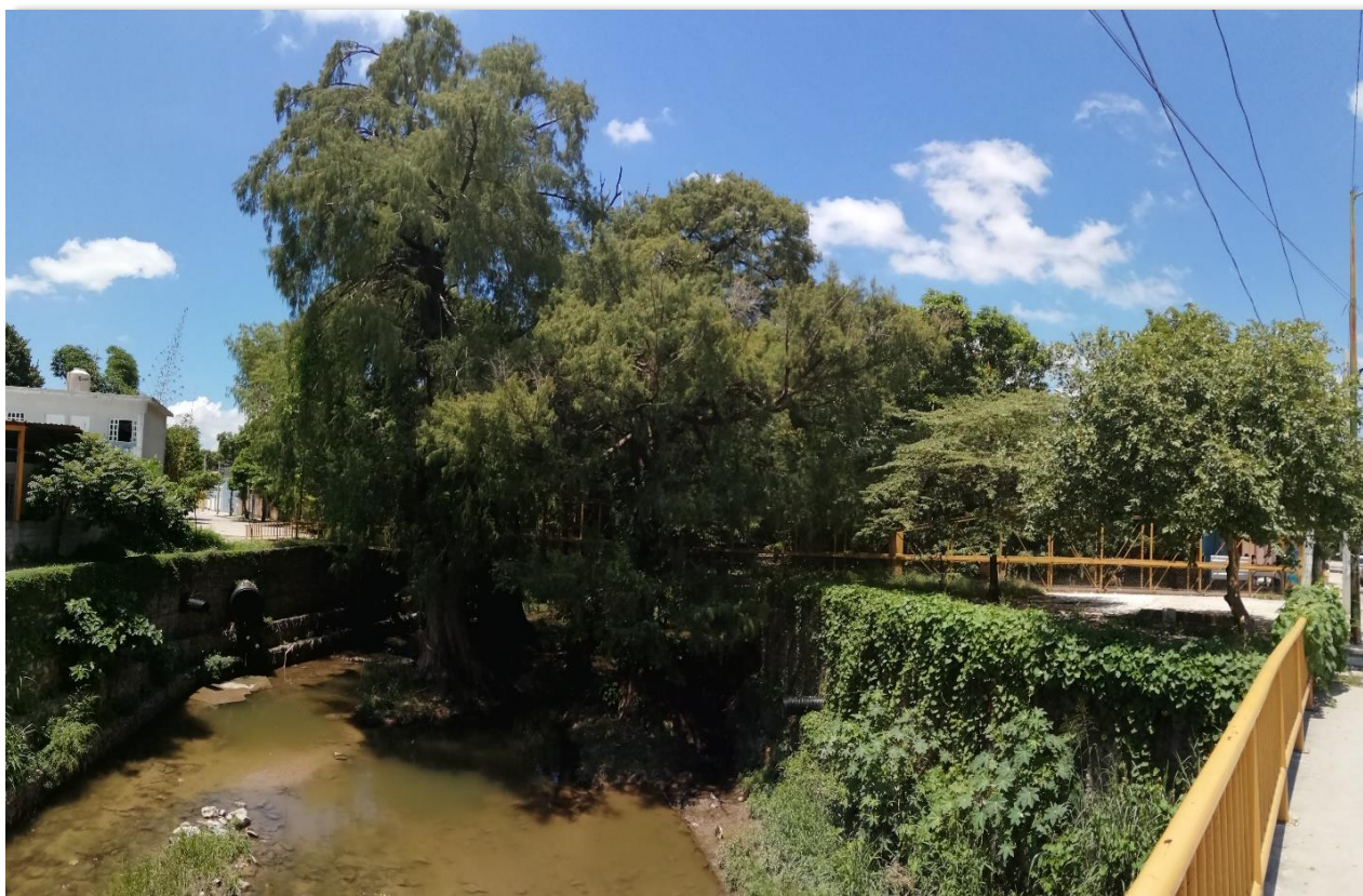
Puente de la 1ª Norte y Calzada de Terán, al fondo se puede observar un puente intermedio que a una calle privada. Foto 332.
