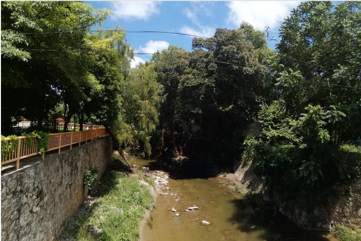
Cruce hacia el otro lado del mismo puente de la Calzada de Terán. Foto 329.
