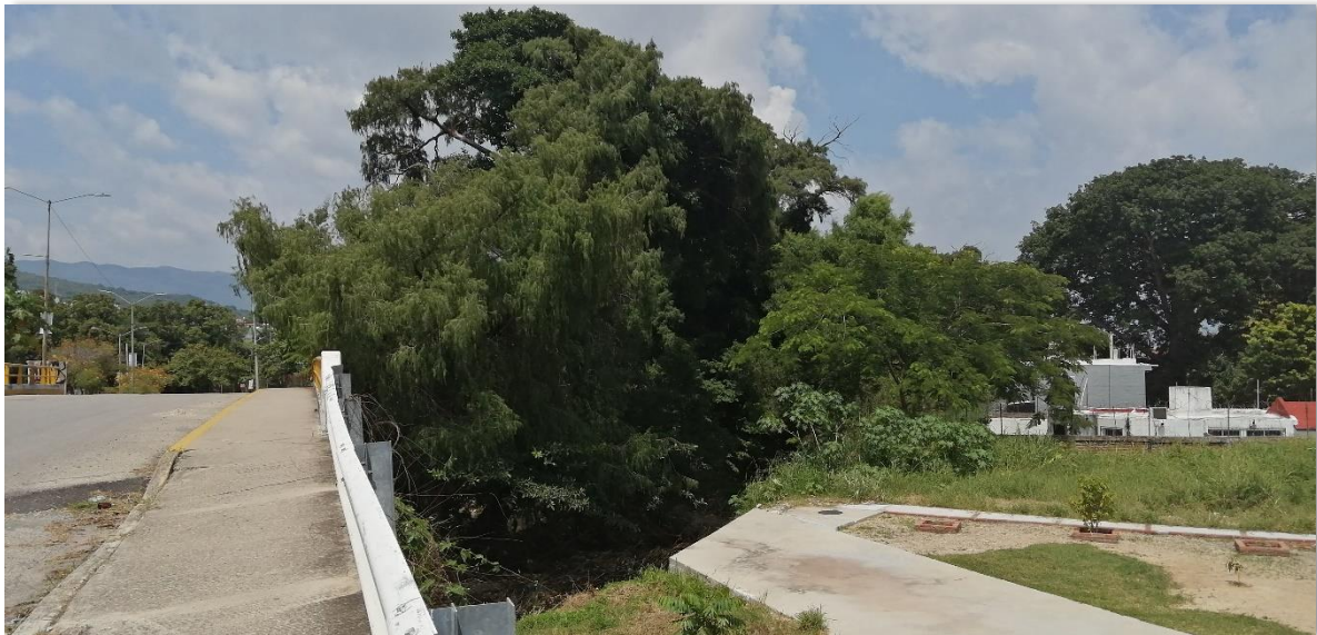
Puente de La Calzada Ciro Farrera aunado a una salida del Parque Tuctlán, cruzando el puente se encuentran los otros andadores en la Colonia Jardines de Tuxtla. Una parte de los andadores del Sabinal fueron acaparados por inmuebles comerciales y viviendas particulares, sin embargo, la mayor parte de los andadores aún mantienen su espacio para que las personas puedan transitarlos.
