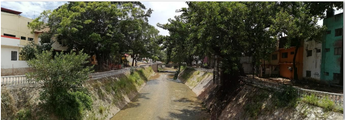
Mismo puente y andadores de la 7ª Poniente entre 4ª y 5 Av. Norte, foto tomada hacia el lado poniente. Foto 193.
