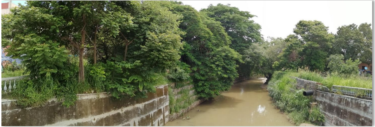
Mismo puente y andadores de la 12 a Poniente entre 4 a y 5 Av. Norte, a partir de aquí la vegetación comienza hacer espesa. Fotografía tomada viendo hacia el poniente. Foto 203.
