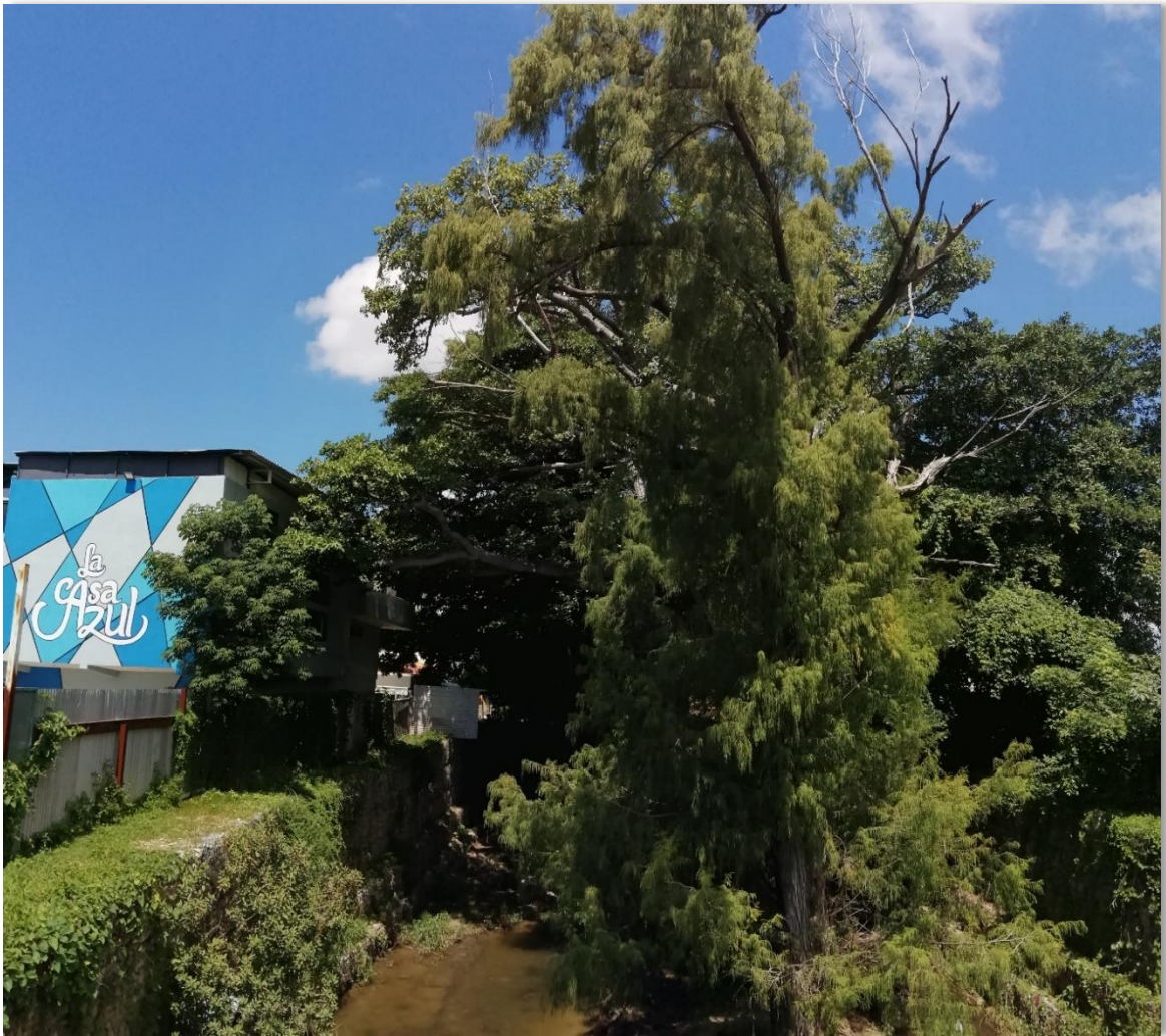
Fotografía del andador del puente de la 3ª Norte y Calza de Terán. Foto 337.
