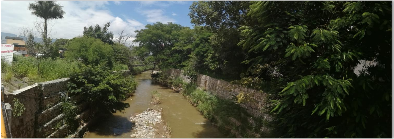
Mismo puente de la 15ª Poniente, al fondo se puede apreciar una parte del Cerro Mactumatza. Foto capturada viendo hacia el oriente. Foto 222.
