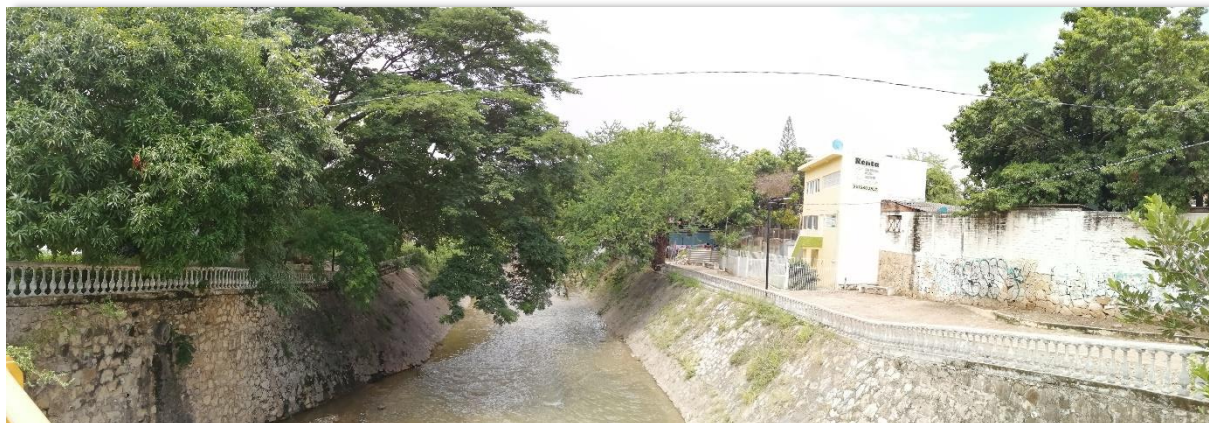
Puente y andadores de la 9ª Poniente entre 4ª y 5 Av. Norte, foto tomada hacia el lado oriente.
