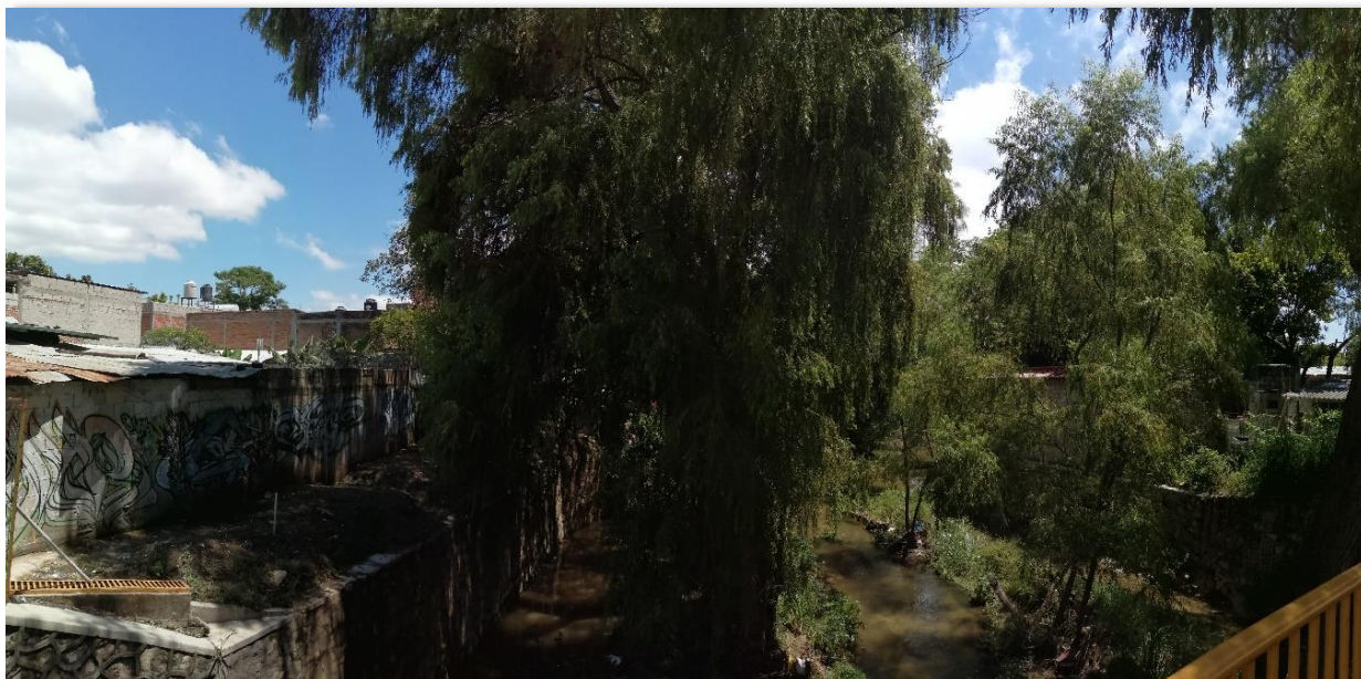
Fotografía del otro lado del puente de la Av. Central Poniente y Calzada Terán. Foto 331.
