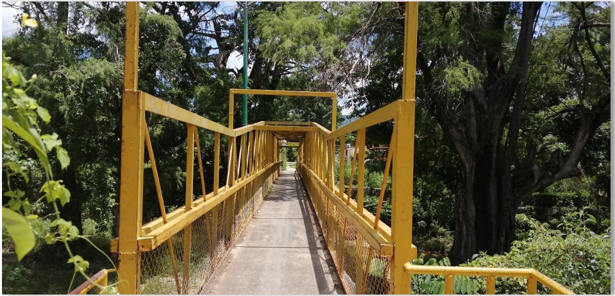
Tercer puente intermedio de la 4ª Poniente y 4ª Sur Terán cerca de la Unidad Habitacional Militar Tuxtla II y La Base Aérea Militar. Foto 350.
