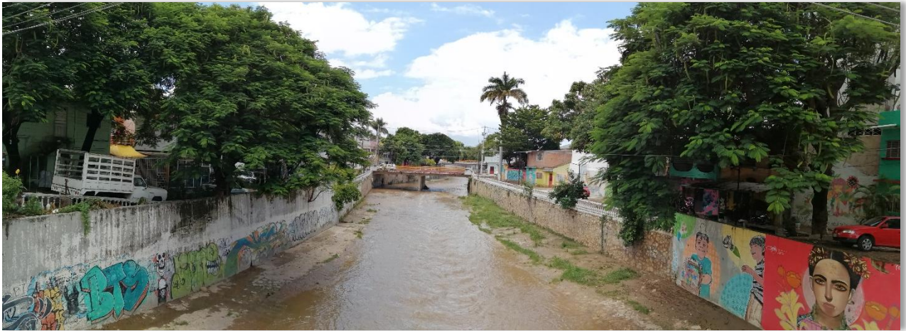
Mismo puente de la Calle Central entre 4 a Norte Poniente y 5 Av. Norte, foto tomada hacia el lado poniente. Foto 179.
