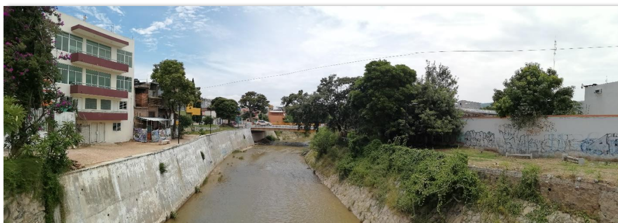
Puente y andadores de la 9ª Poniente entre 4ª y 5 Av. Norte, foto tomada hacia el lado poniente.
