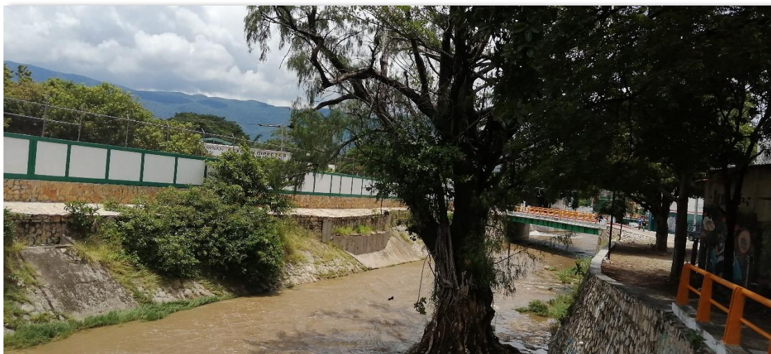
Panorámica tomada desde otro ángulo de Puente de la 5 Av. Norte entre 1ª Oriente y Calle Central, aquí se puede apreciar uno de los contados Arboles de sabino que no fue talado durante el embobamiento del Rio Sabinal. Foto 177.
