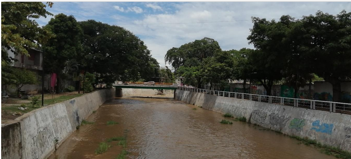
Otro ángulo del puente de la 3ª Oriente, a pesar que en algunos tramos del río los arboles fueron talado, los andadores poseen abundante vegetación y esto se ve reflejado desde el inicio del lado Oriente, así como de lado Poniente de la ciudad.
