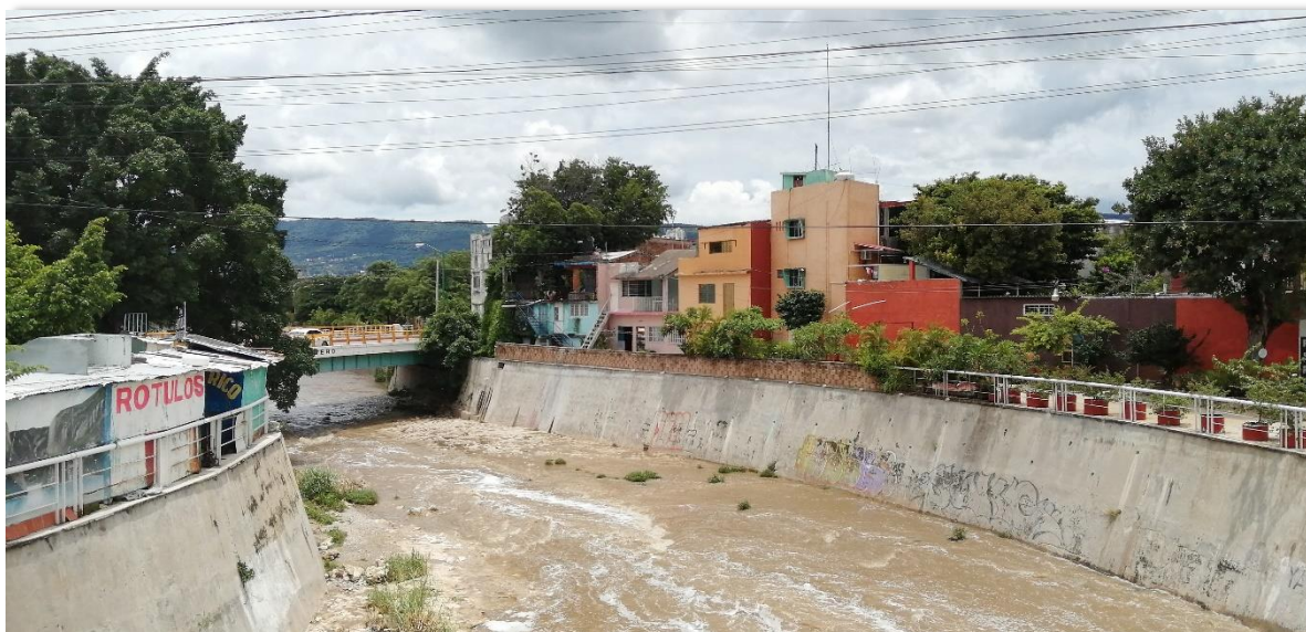
2 puente en la 4 a Norte Oriente entre 5 a y 6 a Oriente Norte, al fondo se puede apreciar El Zapotal/Cerro Hueco. Foto 168.
