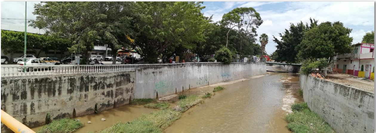
Puente y andadores de la 4ª Poniente entre 4ª y 5 Av. Norte, foto tomada viendo hacia el lado oriente. Foto 186.
