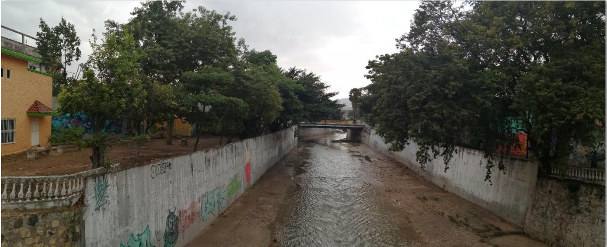
Puente y andadores de la 2ª Poniente entre 4ª y 5 Av. Norte, foto tomada viendo hacia el lado poniente. Foto 182.
