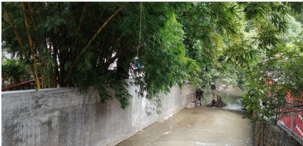
Andadores de La Colonia Fovissste II, sigue la parte contaminada del Rio San Agustín. Foto 296.
