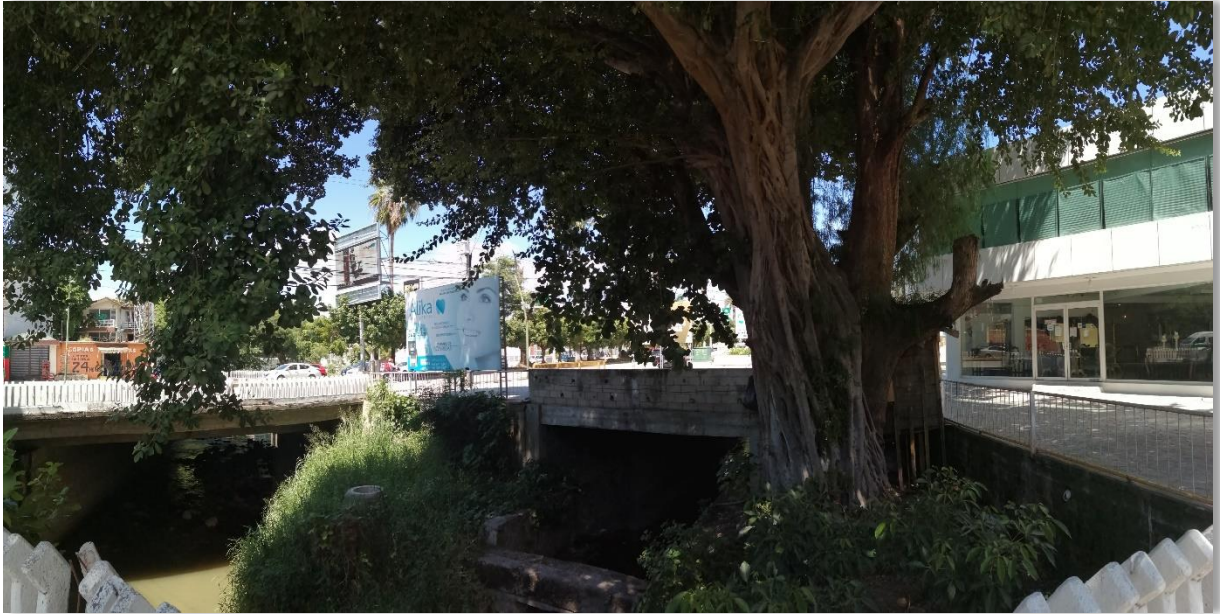
El otro lado del Puente del cruce de la Colonia Fovissste II Jardín Corona y Av. Central Belisario Domínguez.
