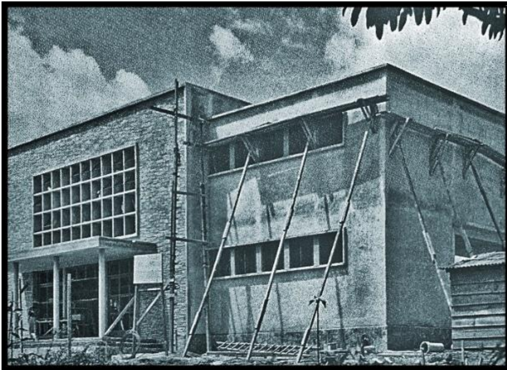
Fotografía de la Construcción del Instituto Botánico 1950. Archivo General del Estado de Chiapas (A.G.E.CH). Área sala Tuxtla.
