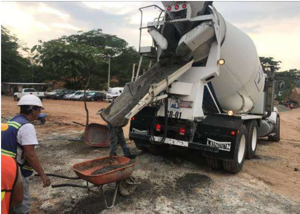
Figura 5.3. Muestreo del Concreto Fresco en Obra.
