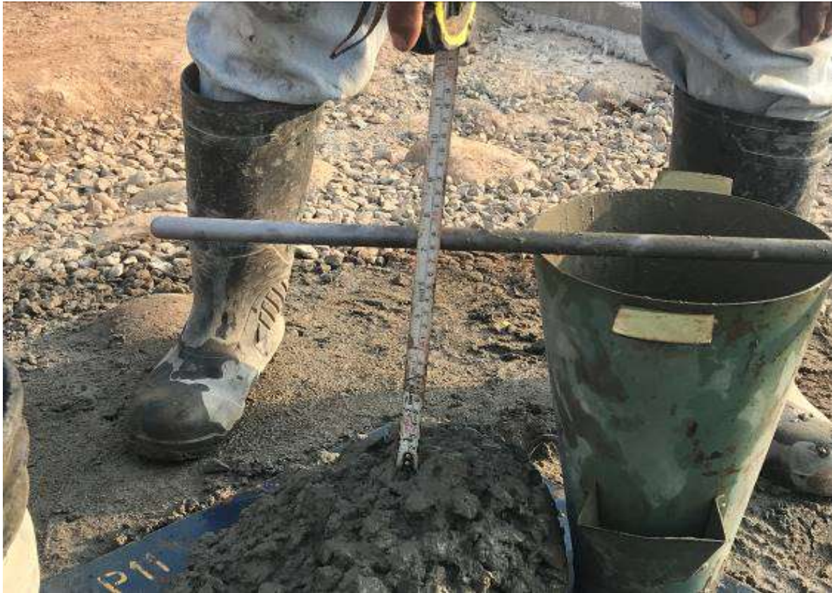
Figura 5.8. Revenimiento del Concreto Fresco en Obra (18 cm).
