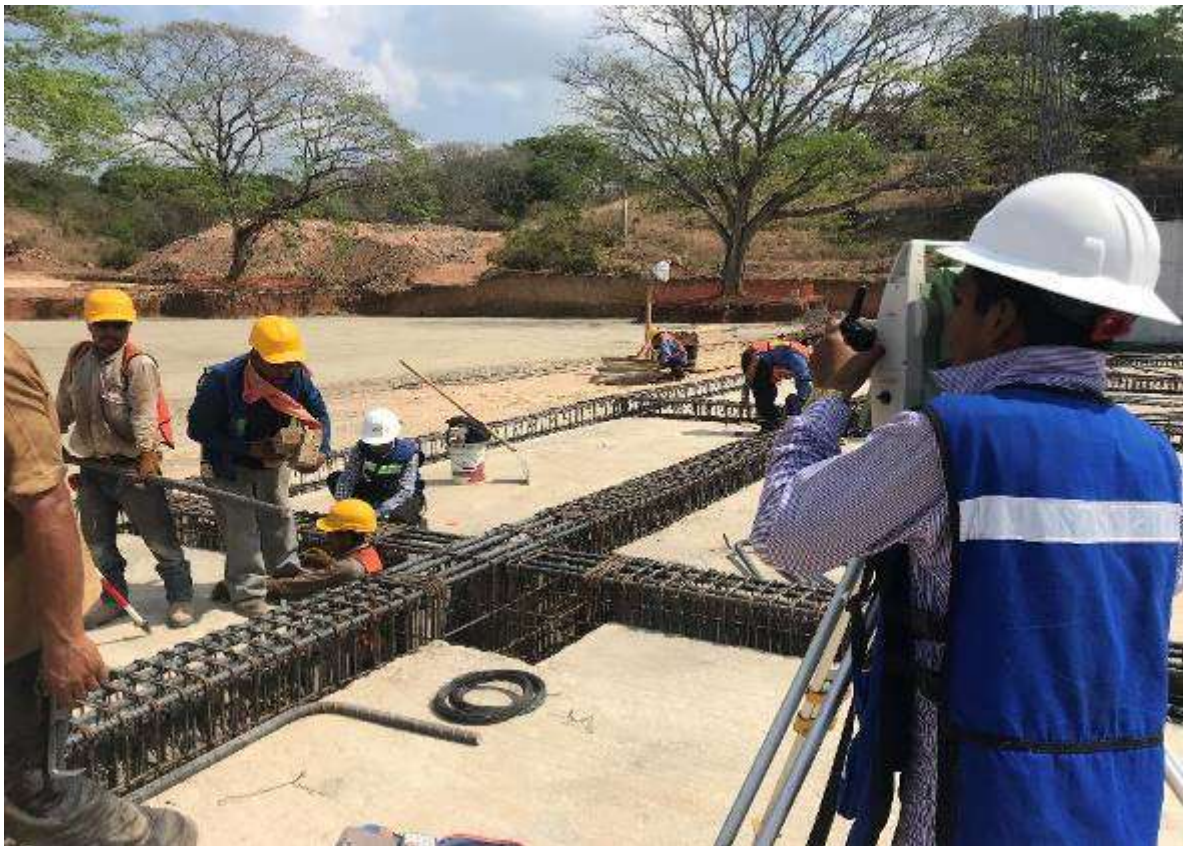
Figura 1. Verificación de Niveles y Centrado del Eje de las Contratabes Para los Dados.
