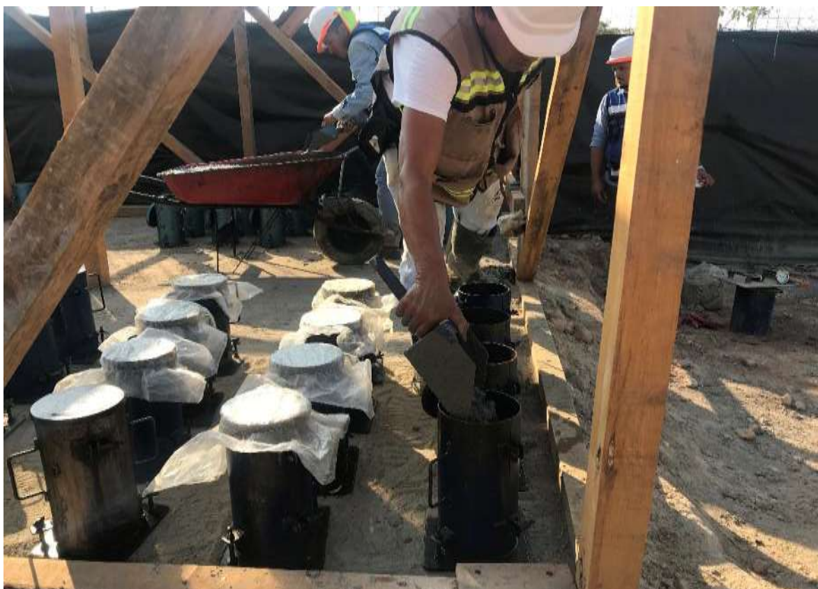
Figura 5.10. Elaboración de Especímenes Cilíndricos del Concreto Fresco en Obra (Llenado).
