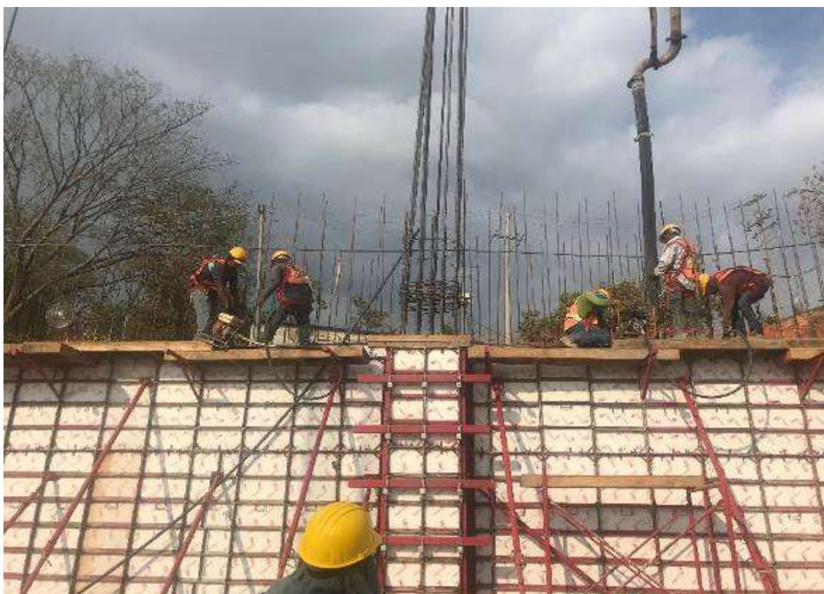
Figura 9. Colado de Muros y Columnas.
