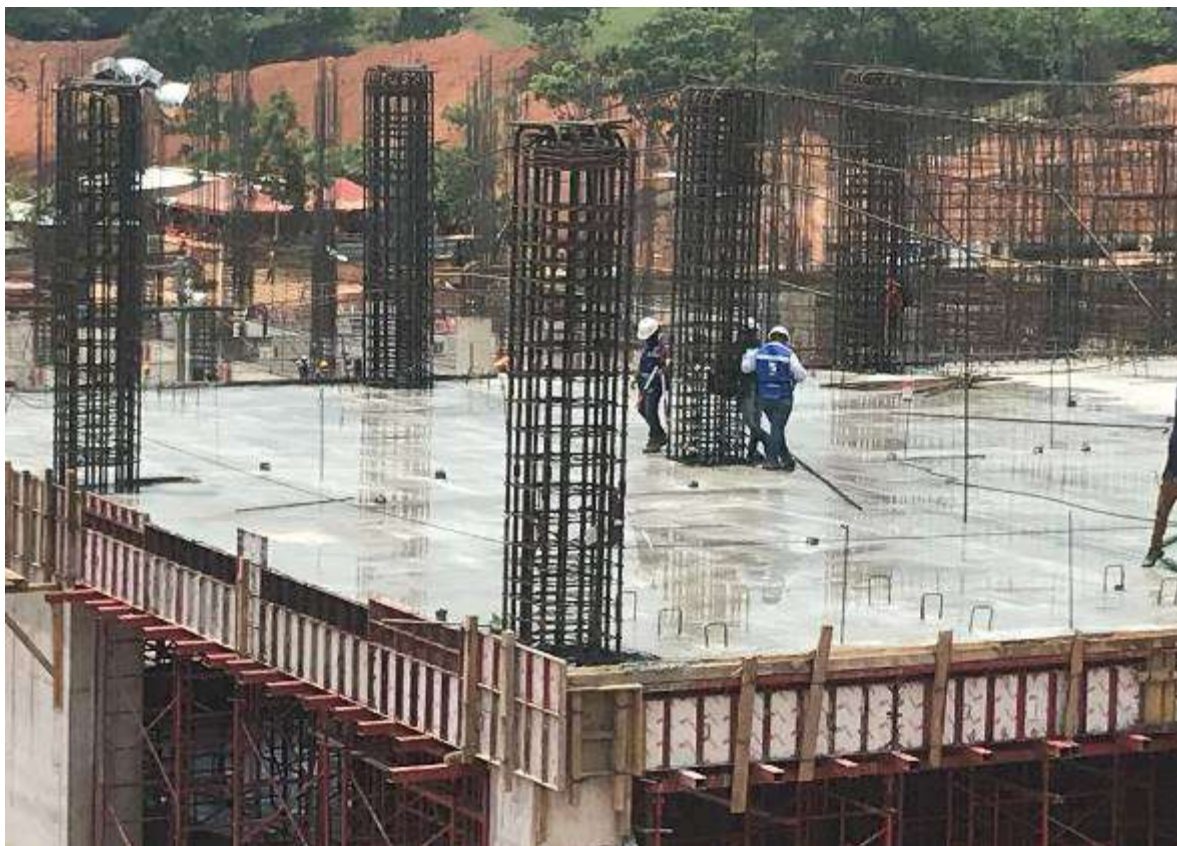
Figura 16. Curado de Losa en Humedo.
