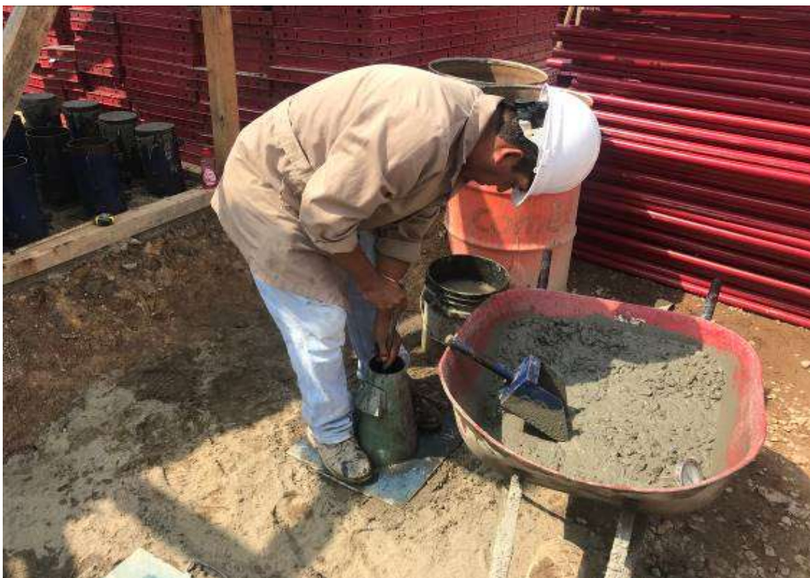
Figura 5.7. Revenimiento del Concreto Fresco en Obra (Compactado con 25 Penetraciones).
