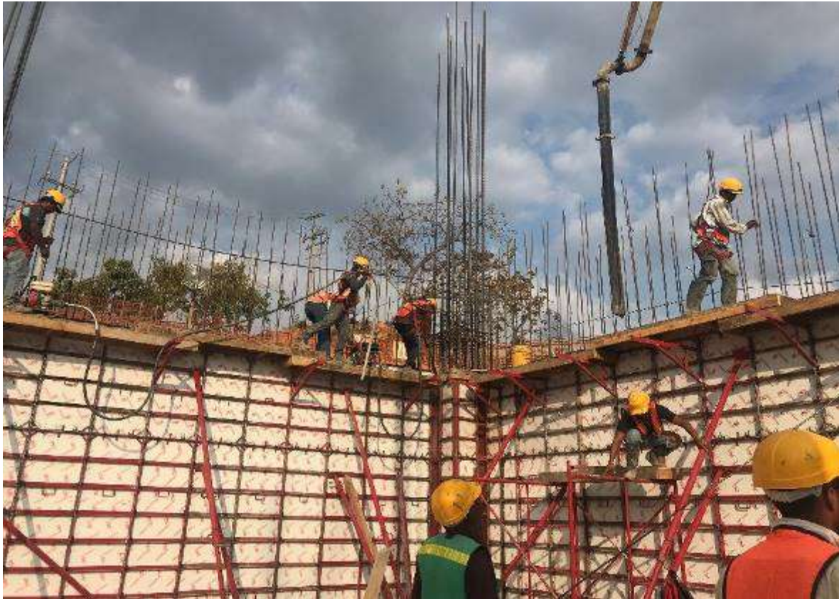
Figura 10. Colado de Muros y Columnas.
