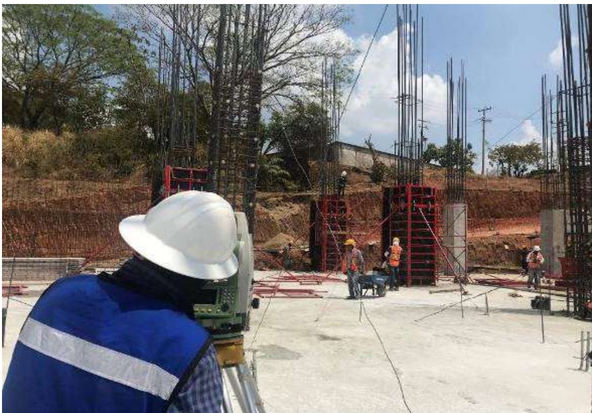
Figura 5. Verificación de Nivel y Plomo de las Cimbras en Columnas (Se Realiza Para Todos los Niveles).
