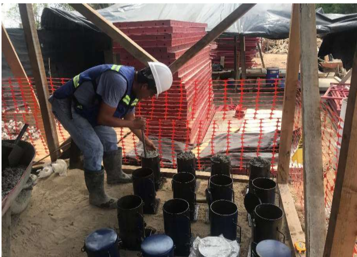
Figura 5.11. Elaboración de Especímenes Cilíndricos del Concreto Fresco en Obra (Varillado).
