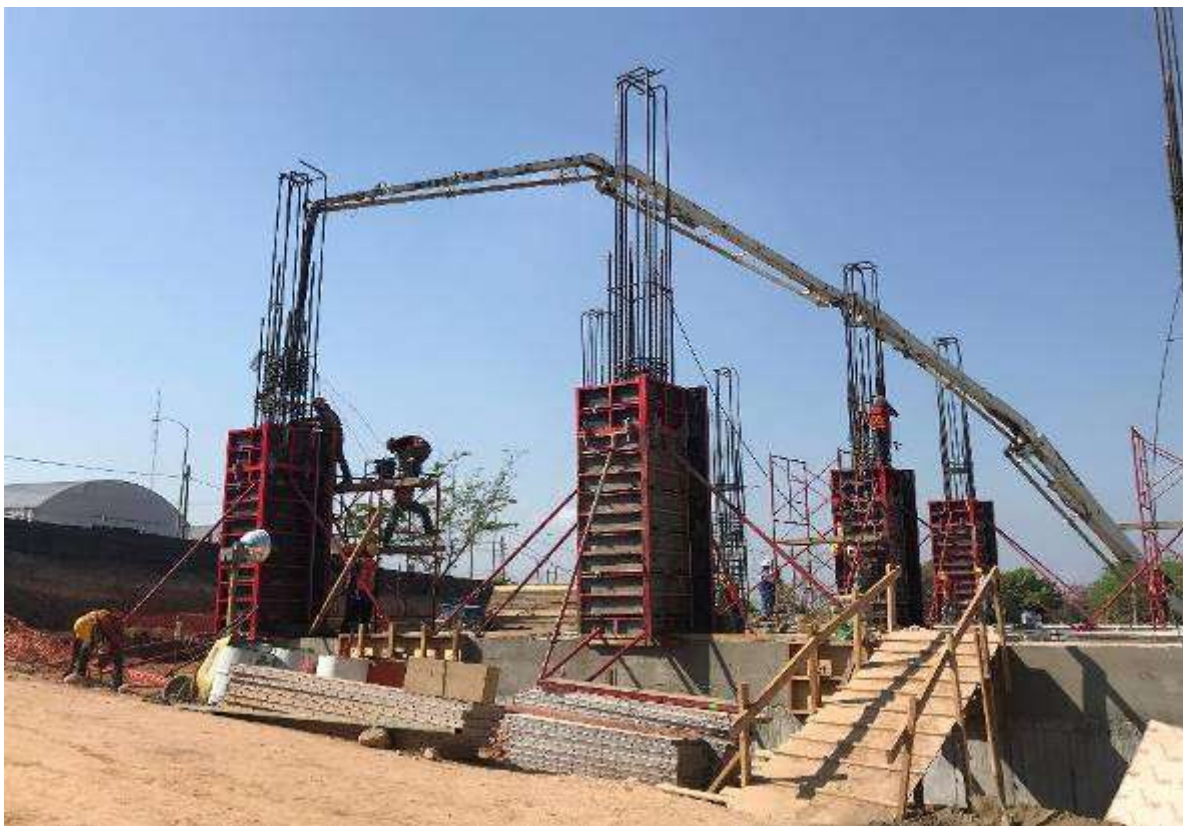
Figura 7. Colado de Columnas.
