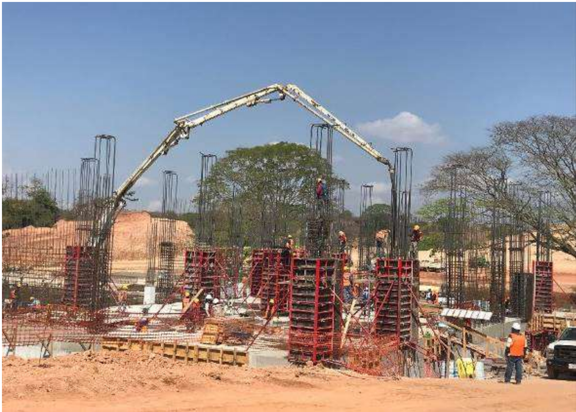
Figura 6. Colado de Columnas.
