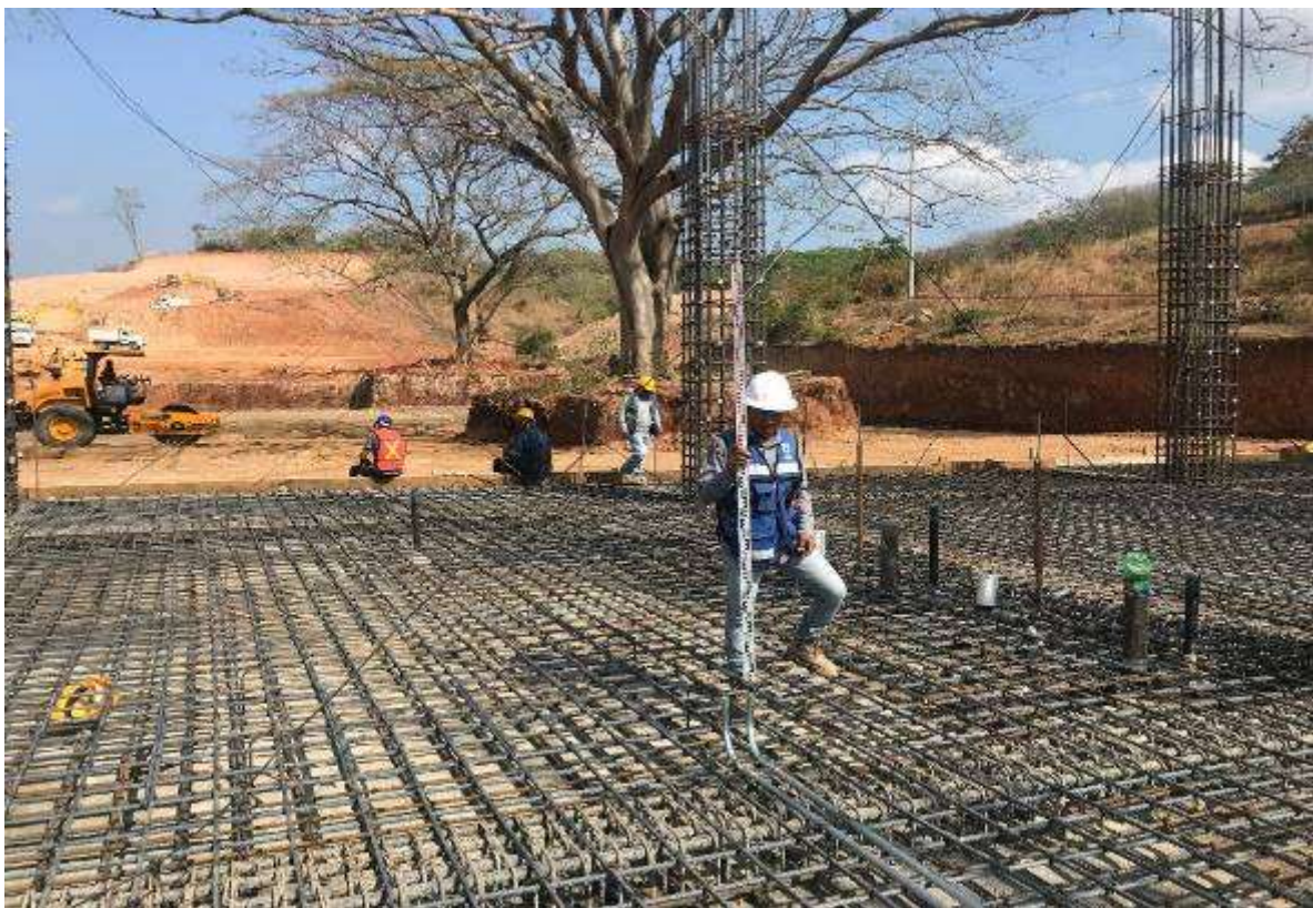
Figura 3. Verificación de Niveles del Acero de Refuerzo en Armado de Losa (Esto se Realiza en Todas las Losas).
