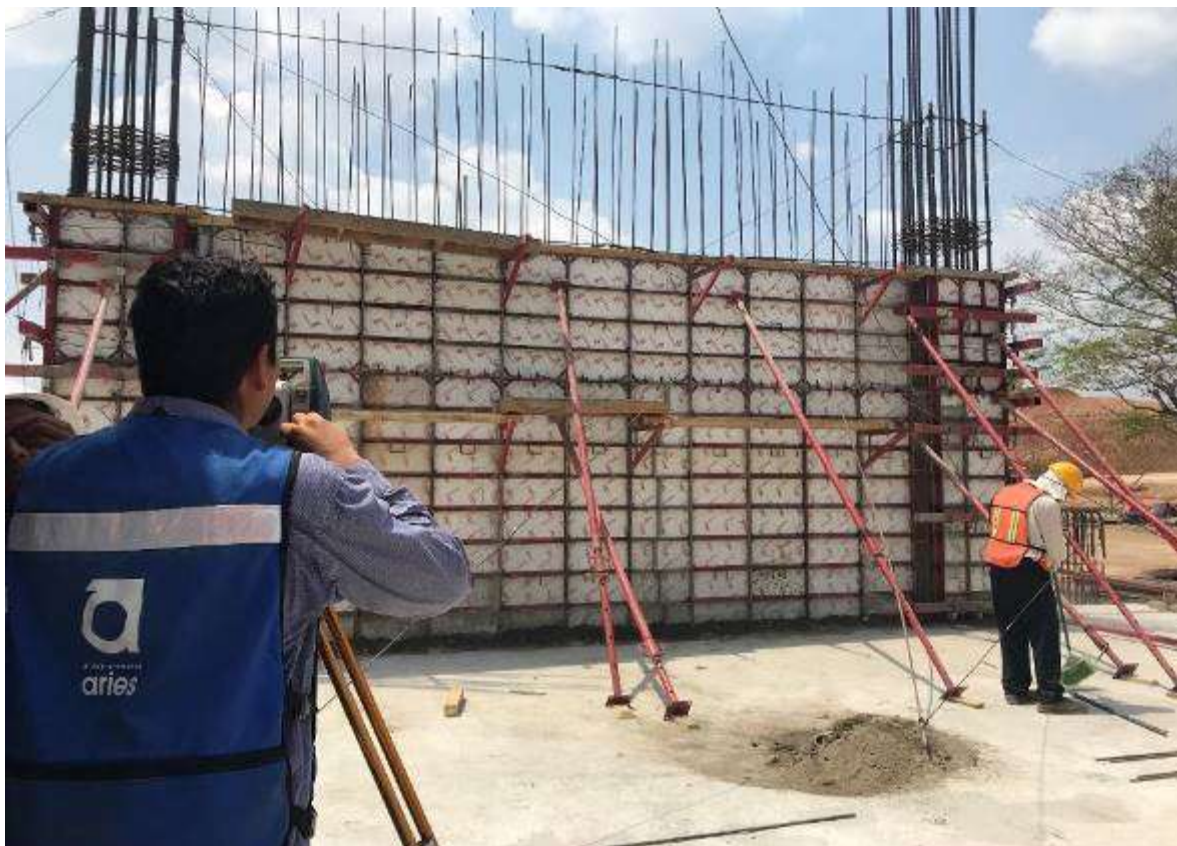
Figura 8. Verificación de Nivel y Plomo de las Cimbras en Muros (Se Realiza Para Todos los Niveles).
