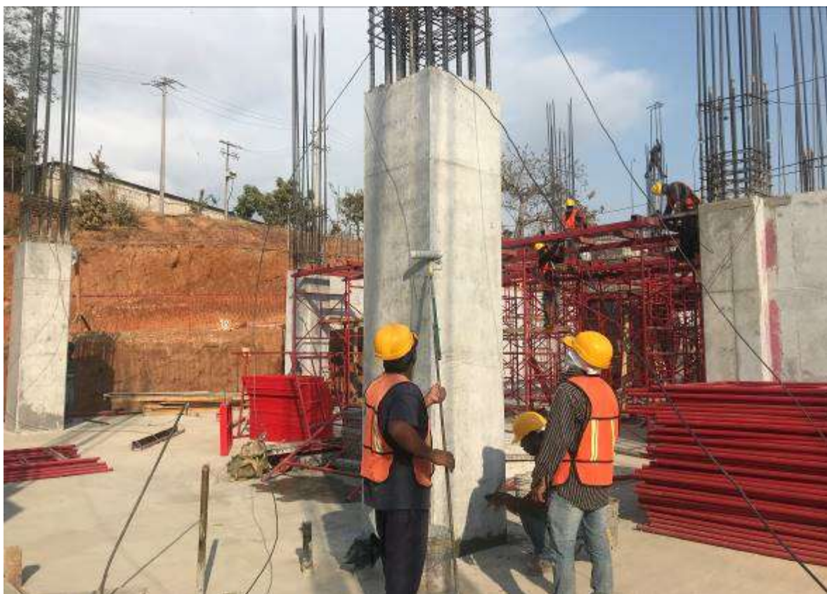
Figura17. Curado de Columnas a Base de Curacreto.
