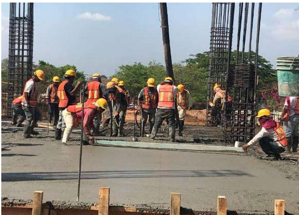
Figura 13. Colado de Trabes y Losa (Acabado).
