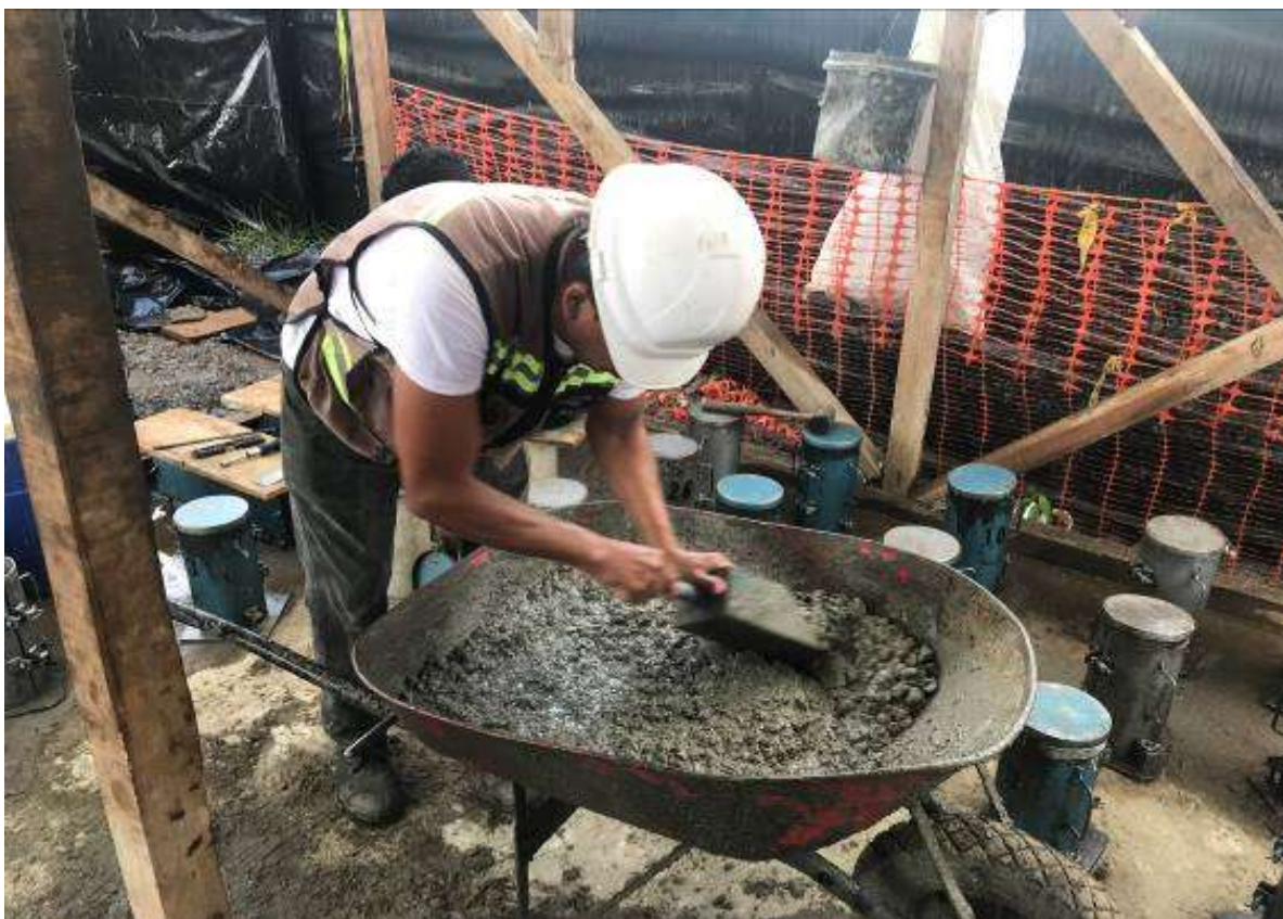
Figura 5.4. Remezclado del Concreto Fresco en Obra.
