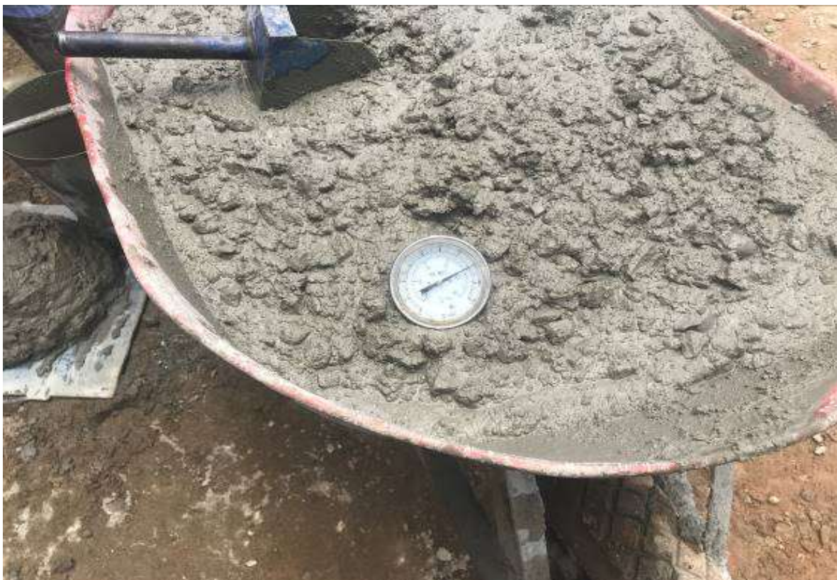
Figura 5.5. Temperatura del Concreto Fresco en Obra.
