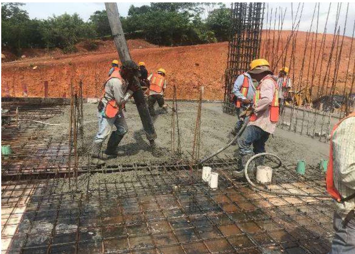
Figura 11. Colado de Trabes y Losa.
