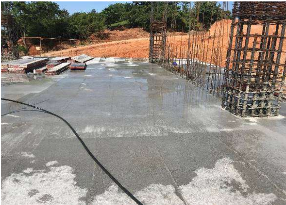
Figura 15. Curado de Losa en Humedo.
