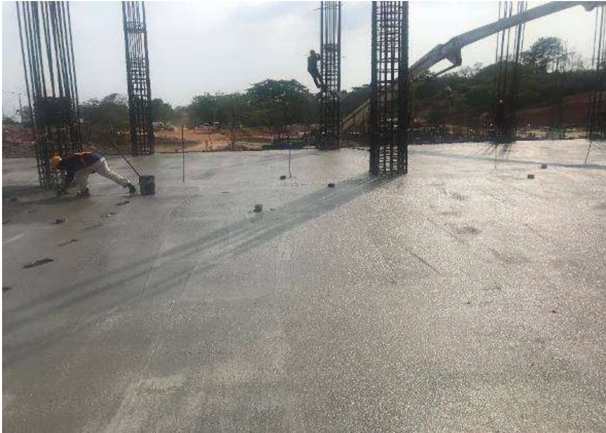
Figura 14. Acabado Final del Colado de Losa.
