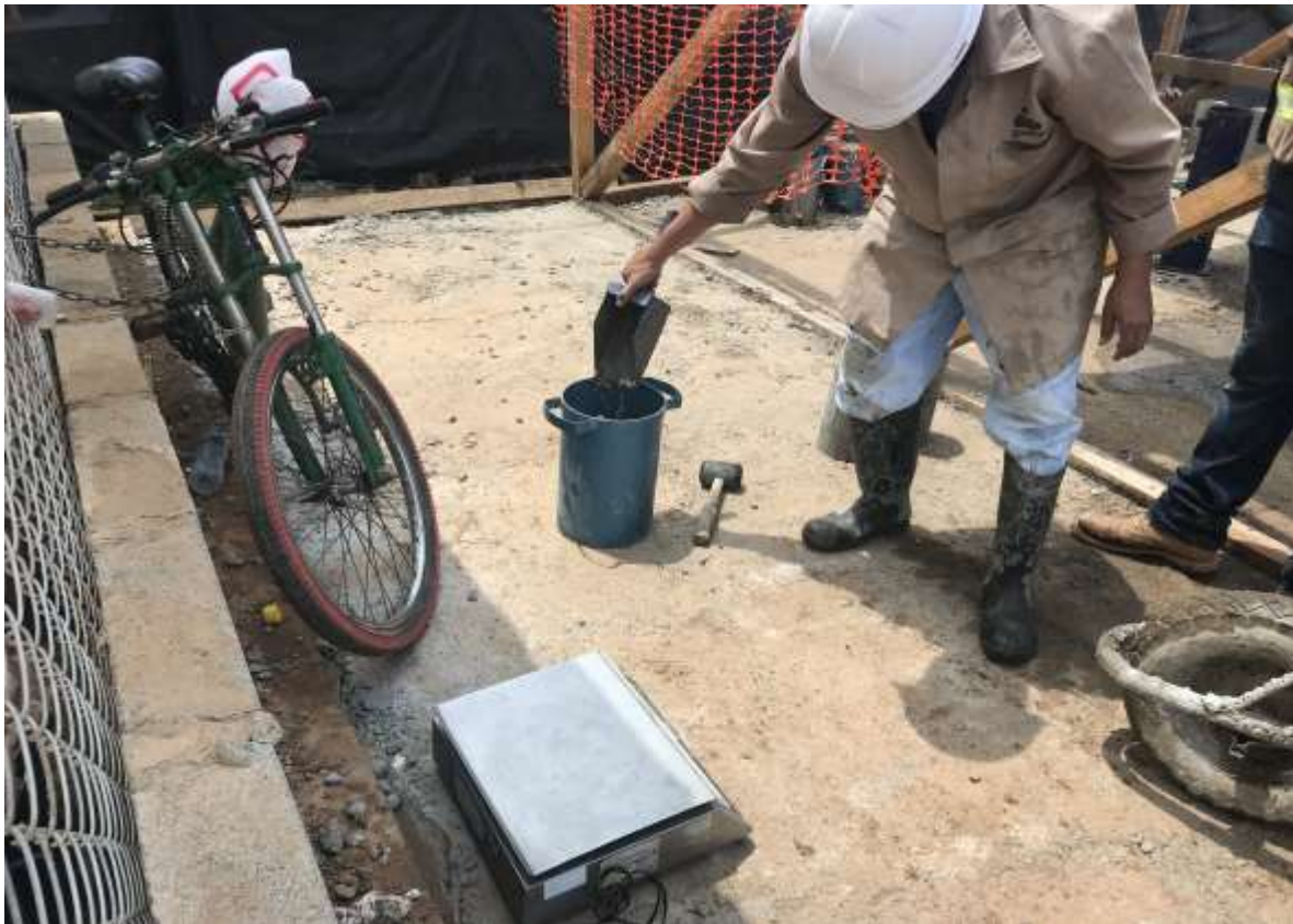
Figura 5.9. Masa Unitaria del Concreto Fresco en Obra.
