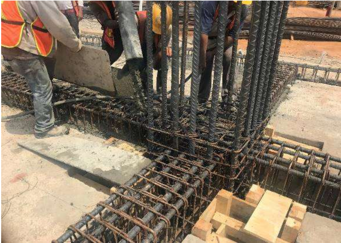
Figura 2. Colado de Contratrabes.
