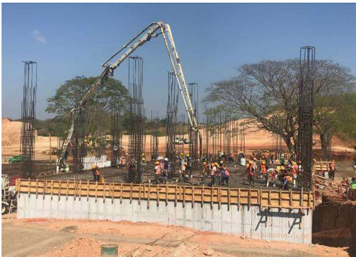
Figura 12. Colado de Trabes y Losa.
