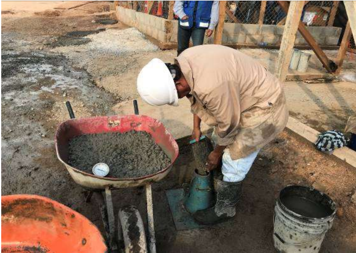
Figura 5.6. Revenimiento del Concreto Fresco en Obra. (Llenado del Cono en 3 Capas del Mismo Volumen).
