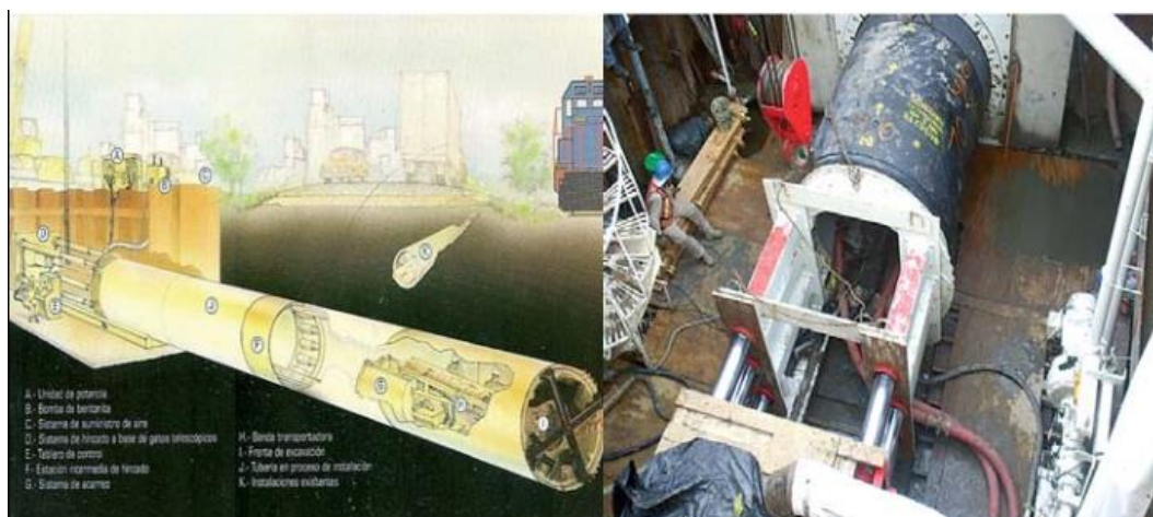
Figura 35. Instalación de tubos por el método de Hincado. Fuente: (Tubocreto, 2008)
