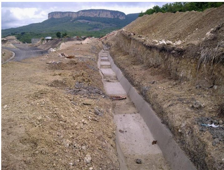
Figura 9. Contracuneta construida en la zona de corte. Fuente (Propia)
