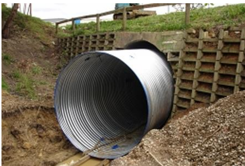
Figura 11. Alcantarilla tipo tubo de lámina corrugada. Fuente (Hengshui Qijia Engineering Materials Co., Ltd., 2016)
