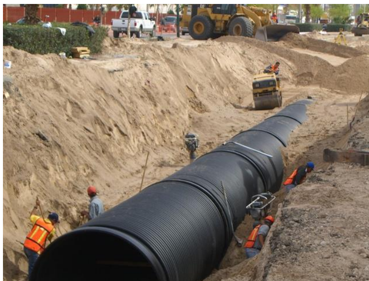
Figura 12. Alcantarilla tipo tubo de polietileno de alta densidad. Fuente (Infraroad, s.f.)
