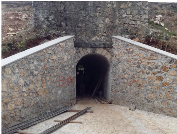
Figura 14. Alcantarilla tipo Bóveda. Fuente (Propia)
