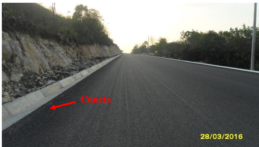
Figura 4. Cunetas longitudinales de sección triangular. (Fuente propia)
