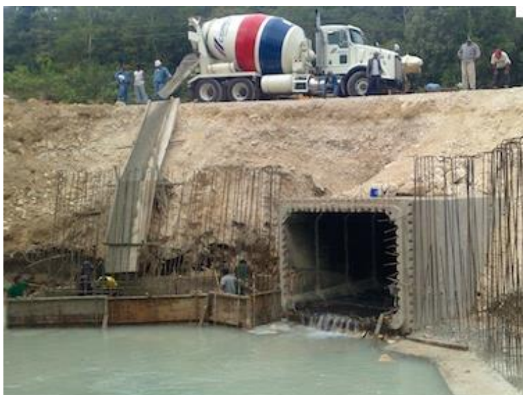
Figura 13. Alcantarilla tipo Cajón de Concreto. Fuente (Tubocreto)
