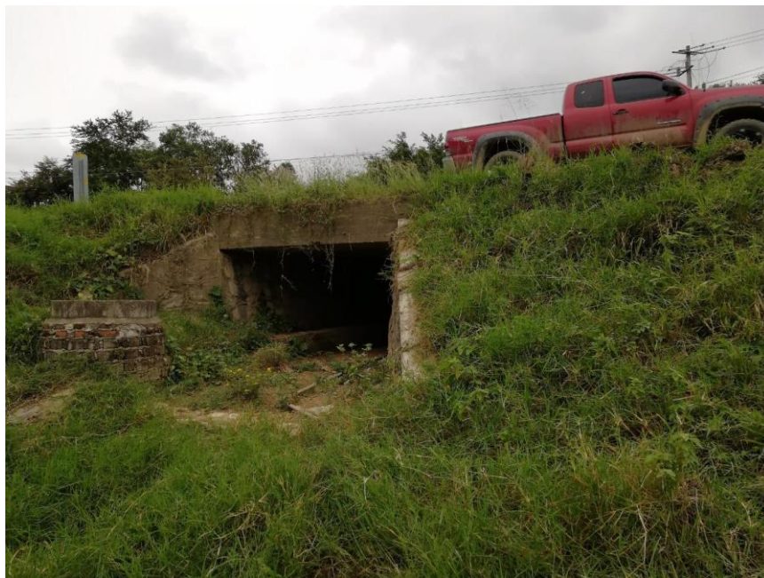
Figura 15. Alcantarilla tipo Losa de concreto. Fuente (Propia)
