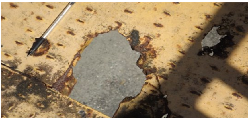
Figura 2.3 Oxidación severa
