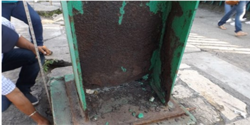
Figura 2.4 Oxidación severa
