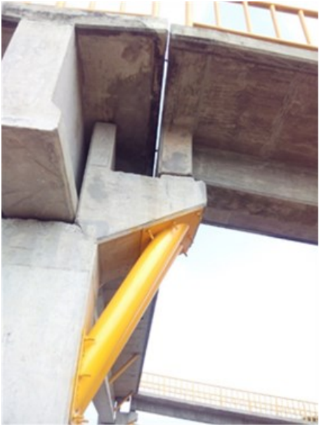
Figura 5.7 Vista de reparación realizada
