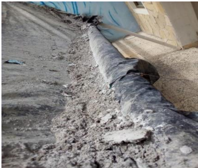
Ilustración 15 Recolección de mortero en obra.
