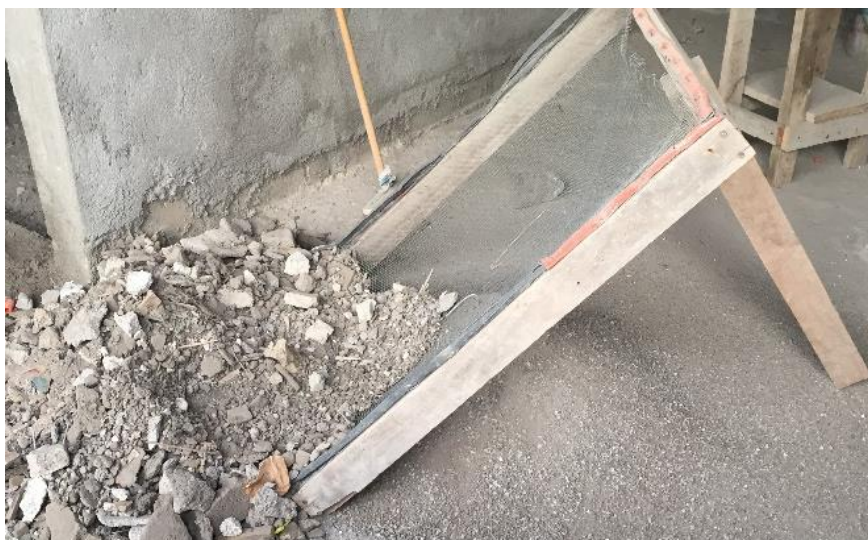
Imagen 20. Cribado de residuos de mortero en obra.
