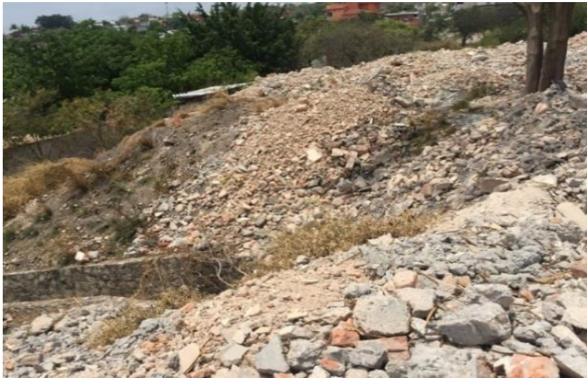
Imagen 3. Inestabilidad de terreno por RCD ubicado en Libramiento Nte. y 5ª Pte. Tuxtla Gutiérrez, 2018.
