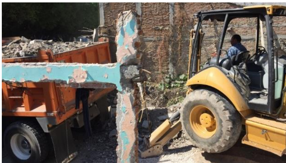
Imagen 3. Carga mediante medios mecánicos de RCD a camiones.
