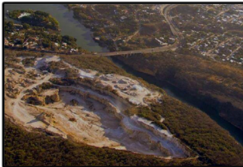
Imagen 2. Vista aérea de la Cantera de Cales y Morteros. Fuente: Expediente de hechos elaborado por la CCA, relativo a la petición SEM-11-02. CCA. © Comisión para la Cooperación Ambiental.
