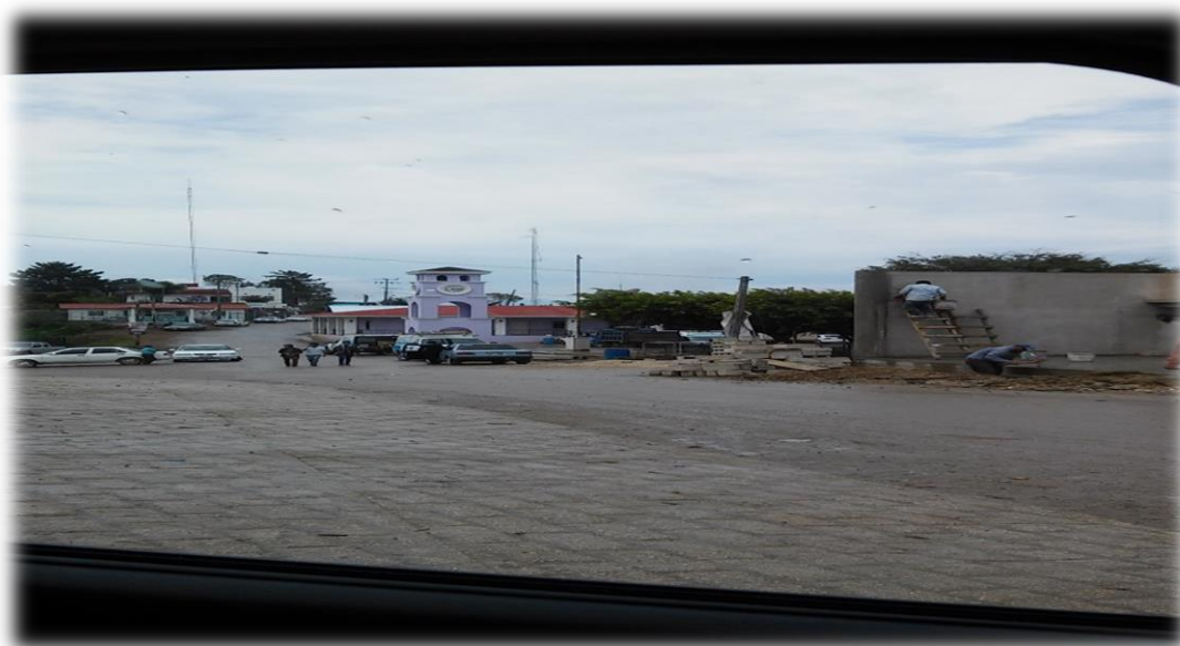
Figura 8. Construcción de la terminal de taxis San Juan Cancuc- San Cristóbal.
