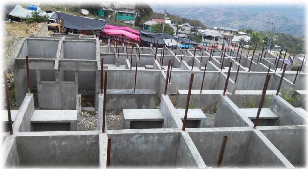
Figura 6. Mercado en construcción en la cabecera municipal de San Juan Cancuc.
