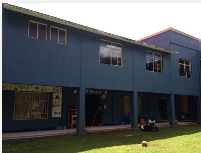
Instalaciones del León XIII
